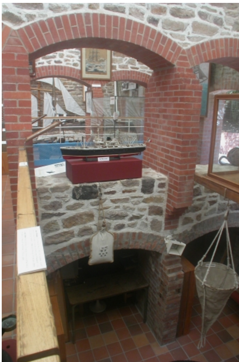
Vue de la fosse le long de la façade postérieure
