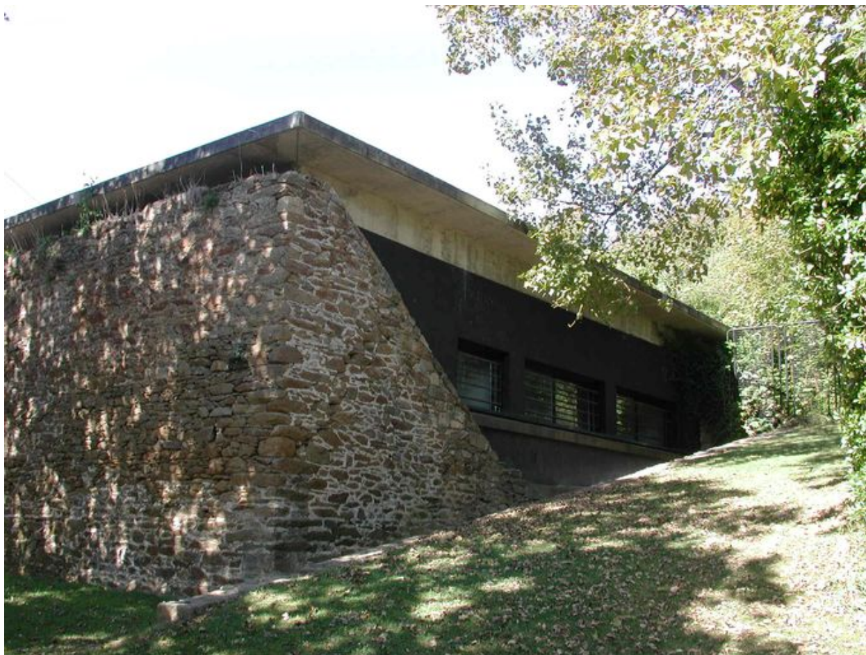
Vue du fort du Dellec : édifice ancien transformé
