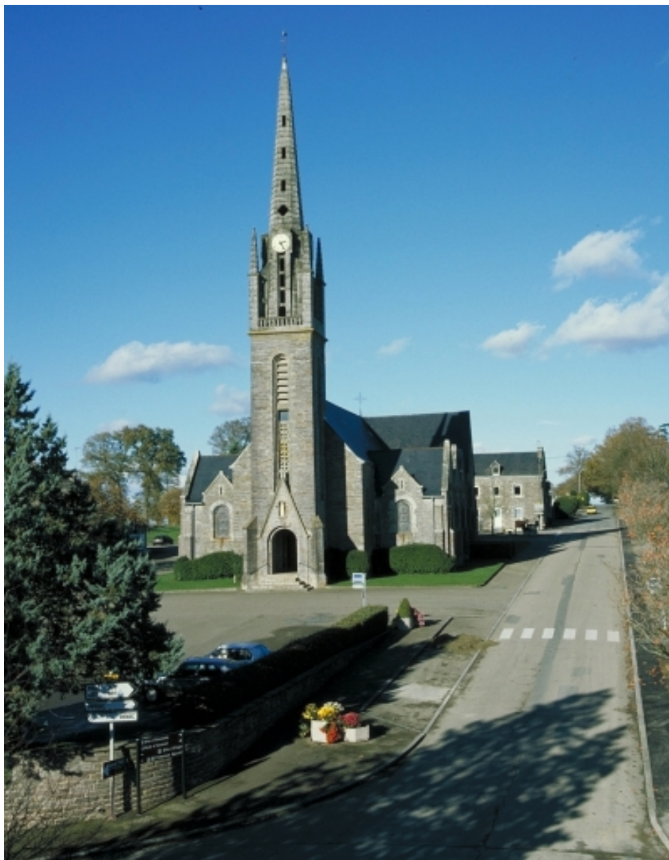
Vue de situation : façade sud
