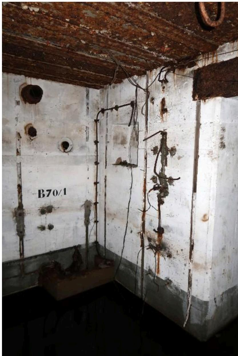
Vue intérieure : salle de garde nord, angle nord-est. Au sol, les arrivées des câbles téléphoniques du boîtier de connexion [disparu] qui était fixé au mur. Sur le mur nord se trouve peint le numéro du bunker : B 70 / 1
