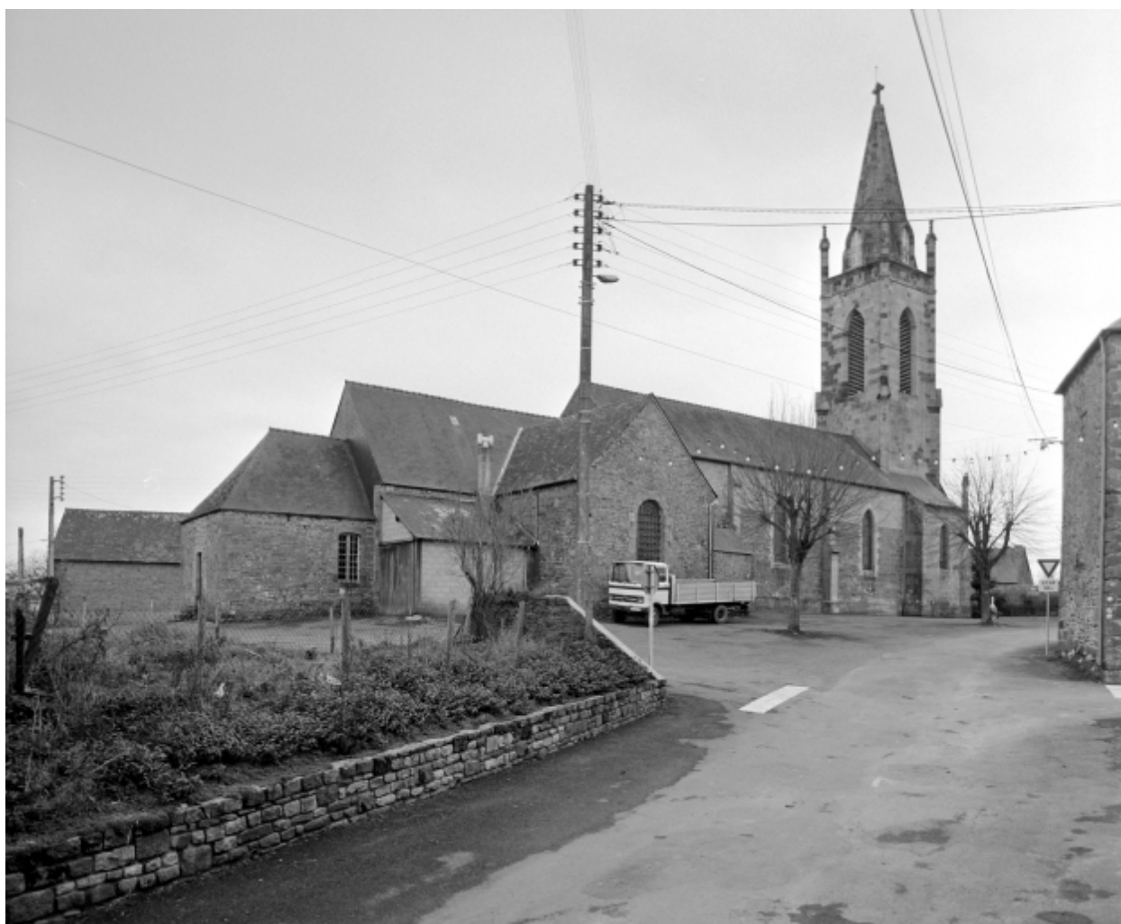
Elévation nord-est : vue générale
