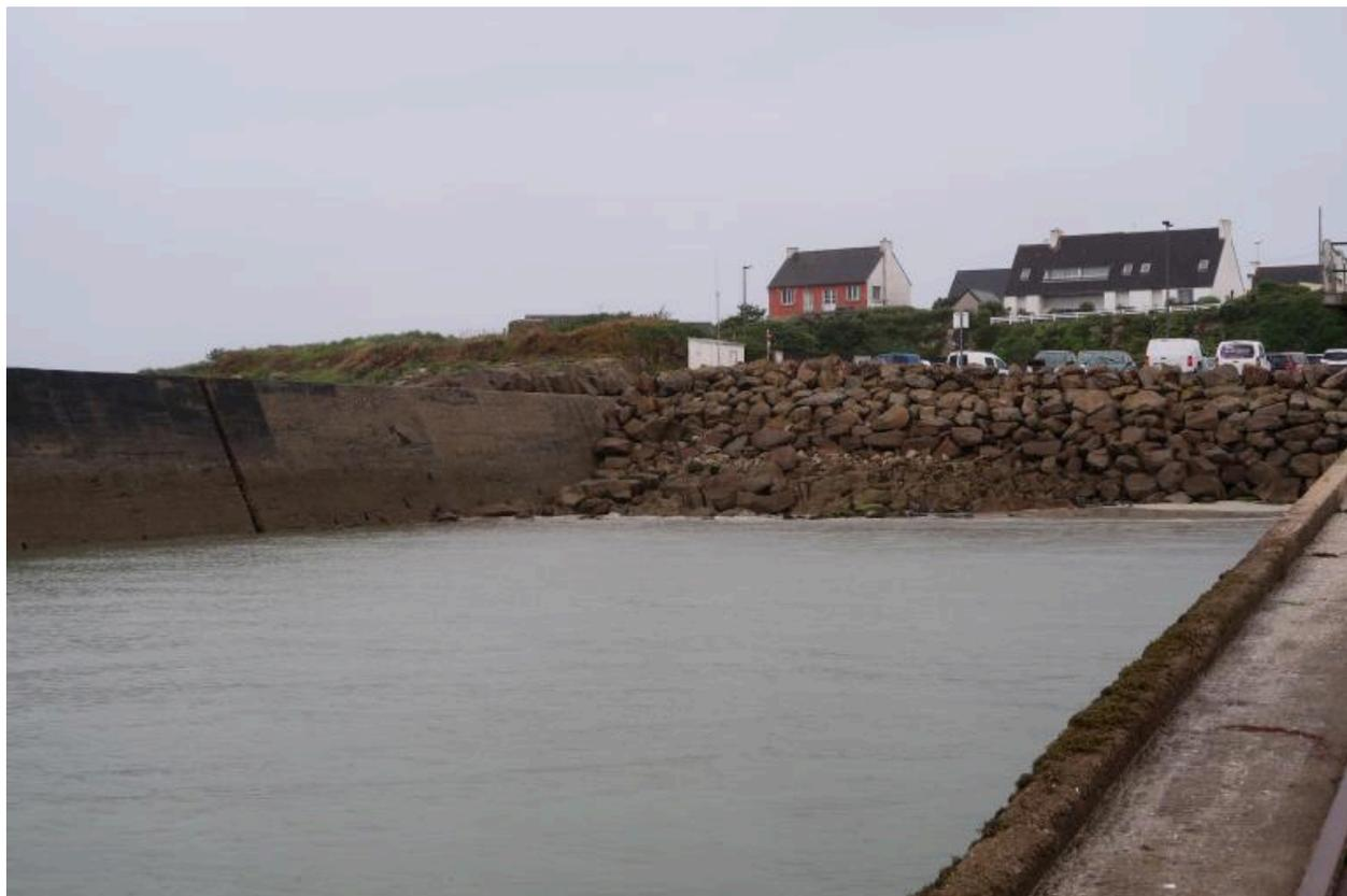
Enrochement entre la digue et la cale de l'abri du canot de sauvetage ; terre-plein du parking
