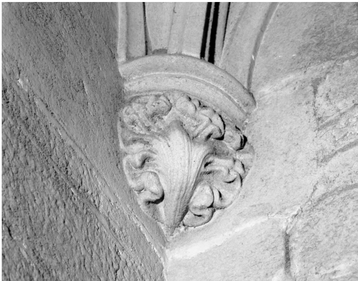
Rez-de-chaussée, couloir : détail du cul-de-lampe sud est
