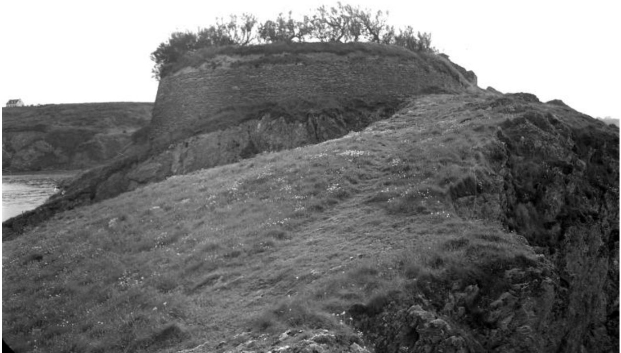
Ancienne batterie, côté mer
