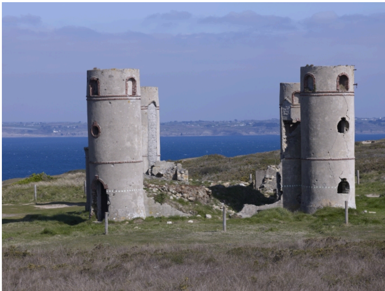
Ruines de l'ancien manoir du Boulτους : ancienne façade sud
