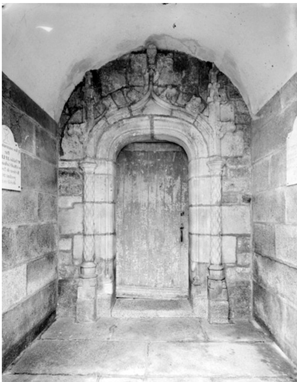
Intérieur du porche, côté sud
