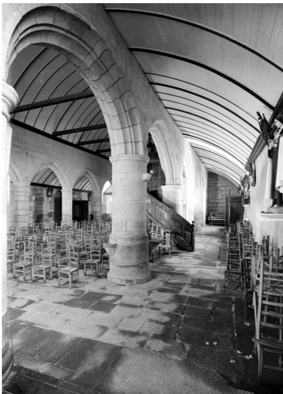
Bas-côté nord : vue générale vers l'ouest
