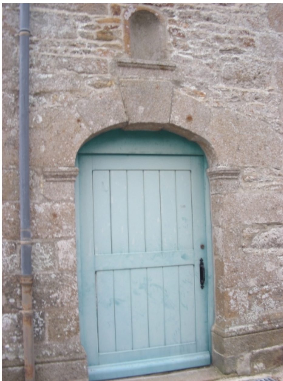
Porte de la façade nord
