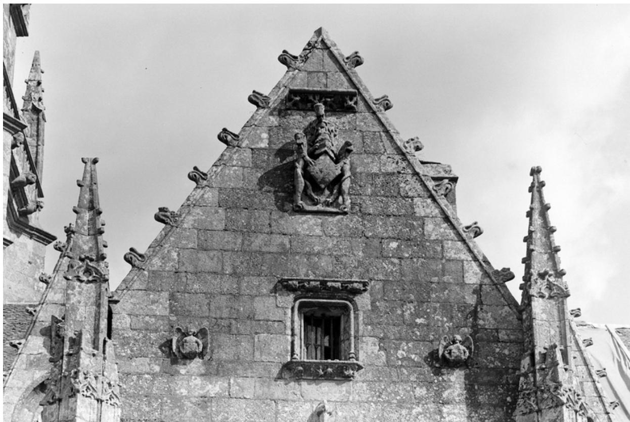
Façade sud, porche : détail du fronton
