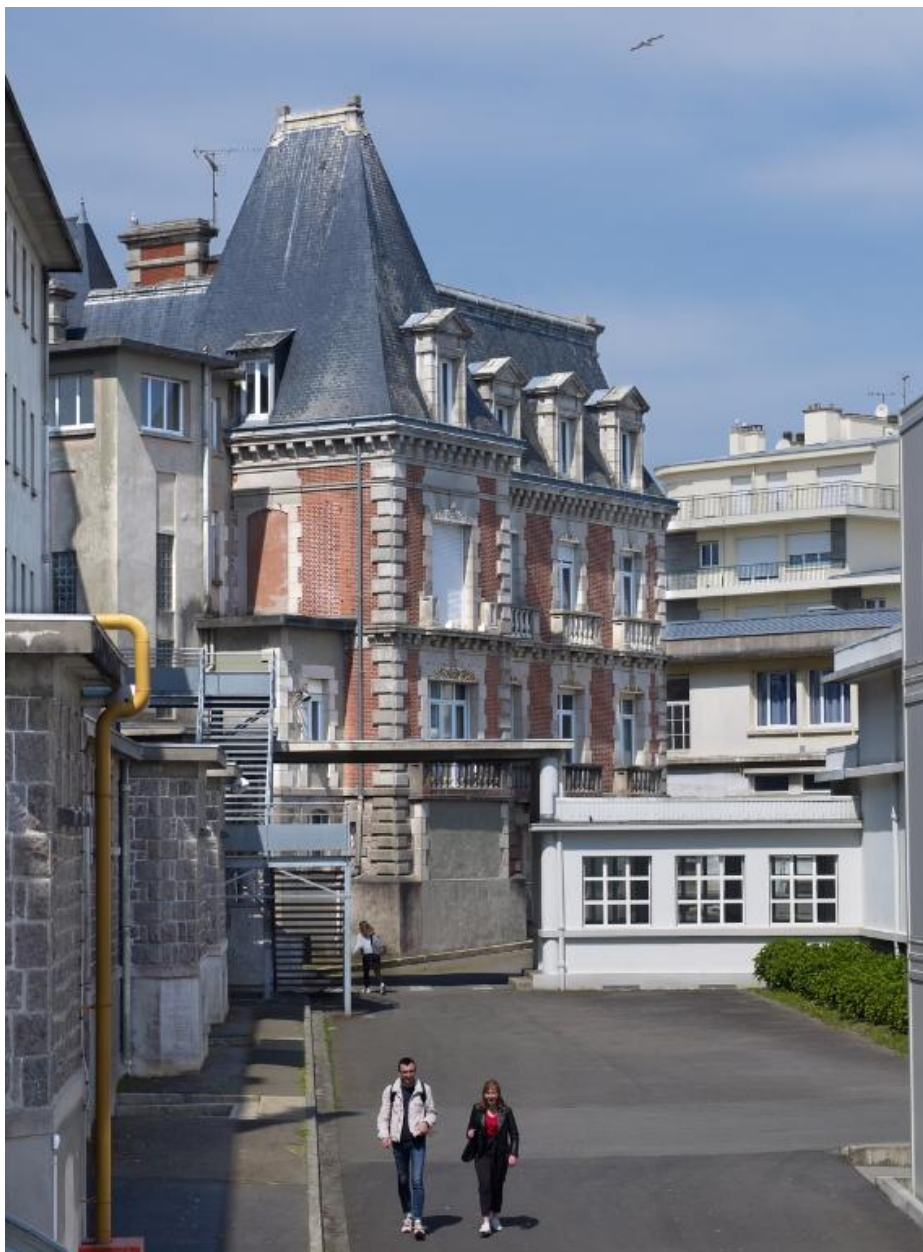
Galerie de liaison entre l'internat et le gymnase (actuel amphithéâtre) et ancienne Villa Baratoux (bâtiment administratif + logement du proviseur). Vue prise depuis le sud-est.
