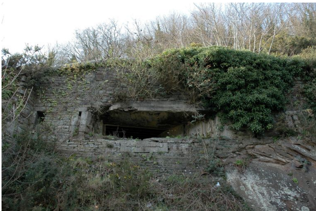
Vue d'une casemate pour canon de 47 mm antichars intégrée dans le mur défensif de la porte de la Brasserie à Brest
