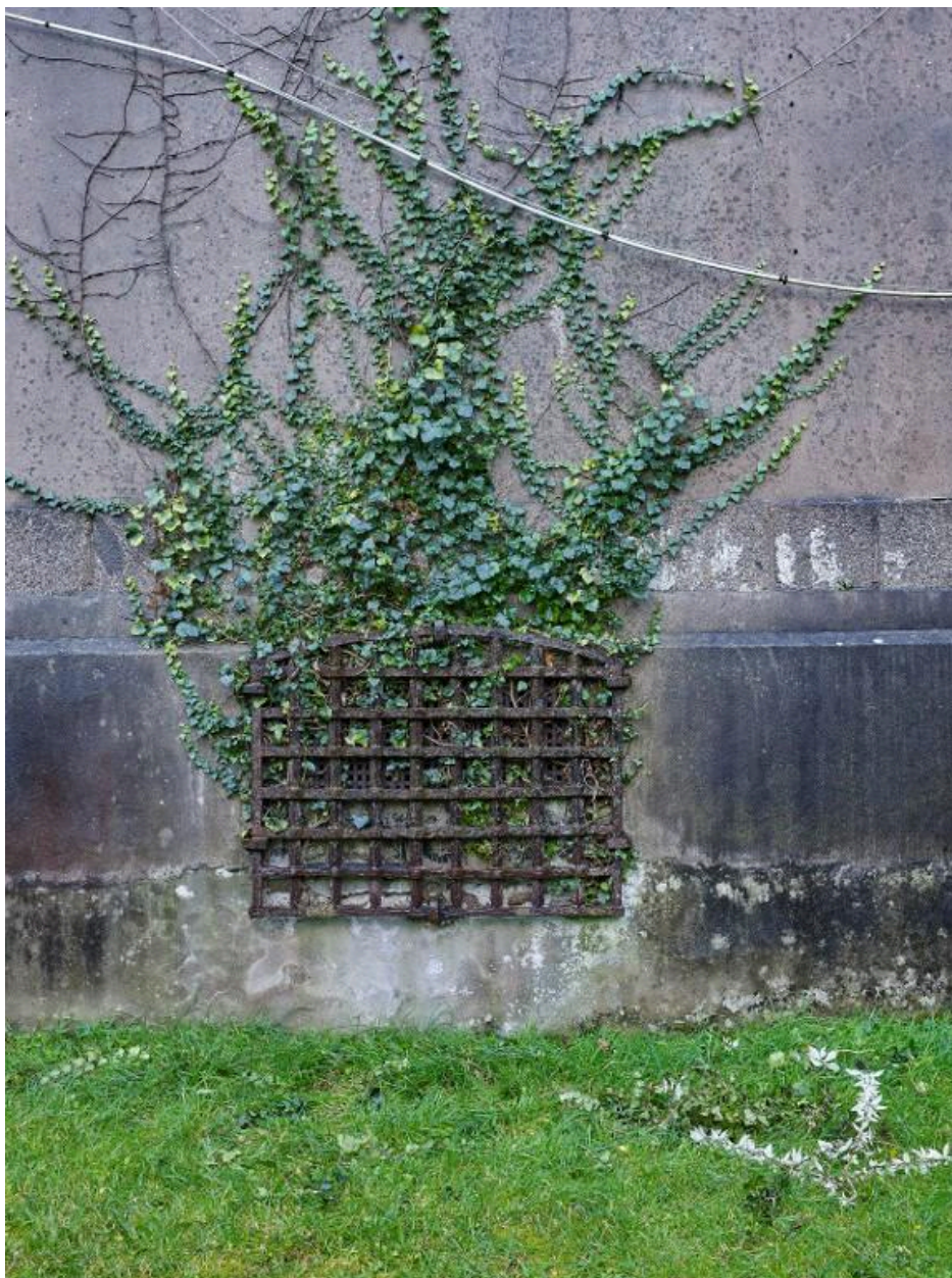
Vue de détail du pignon nord du bâtiment carcéral : fenêtre dotée de deux grilles (l'une à l'extérieure, l'autre à l'intérieure). Le lierre grimpant colonise les lieux
