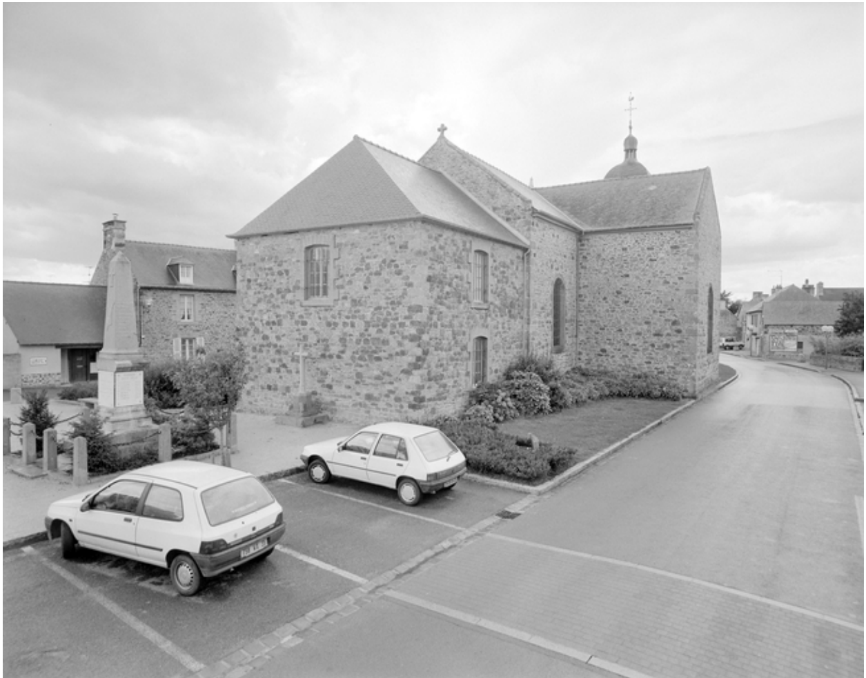
Elévation Nord-Est : vue générale.
