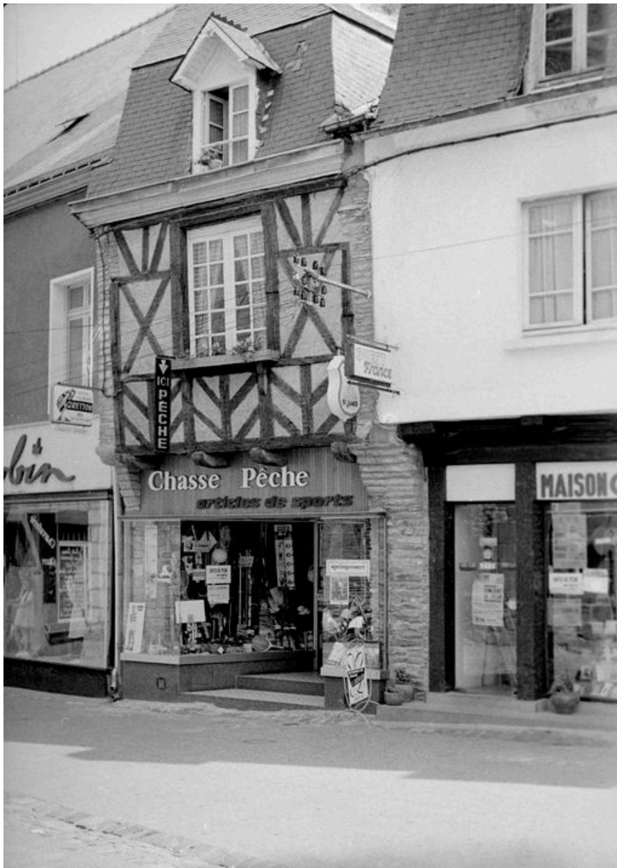
Elévation nord-ouest (état en 1969)
