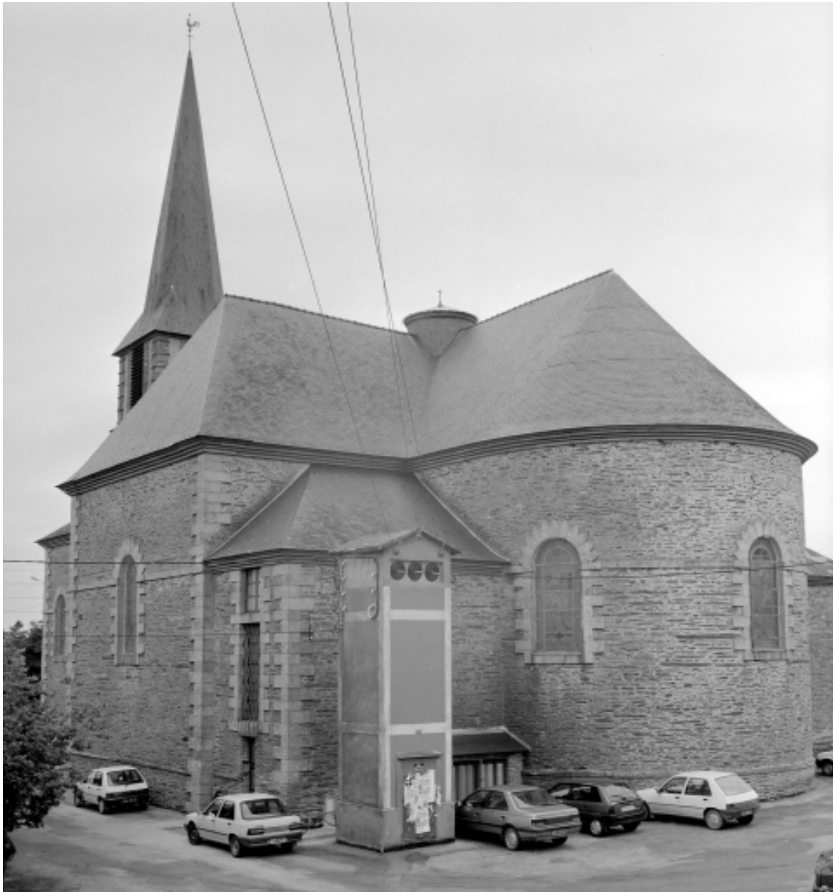
Elévation sud-est : vue générale
