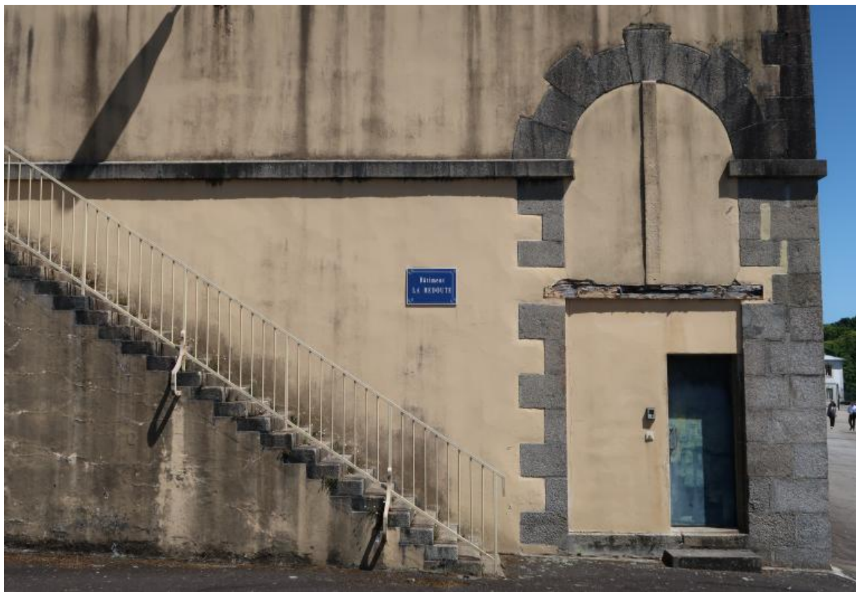
Vue du pignon ouest : baie murée (état en 2022)
