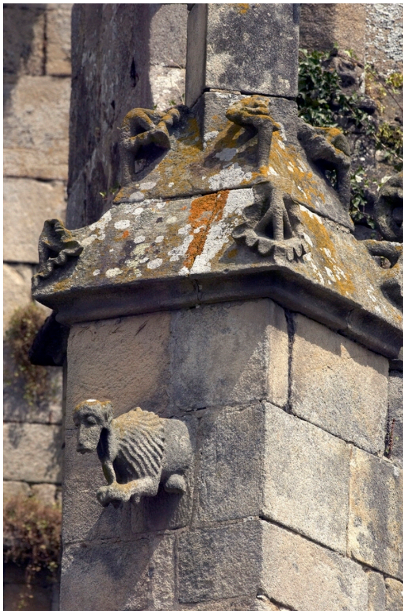
Détail contrefort ouest de la sacristie
