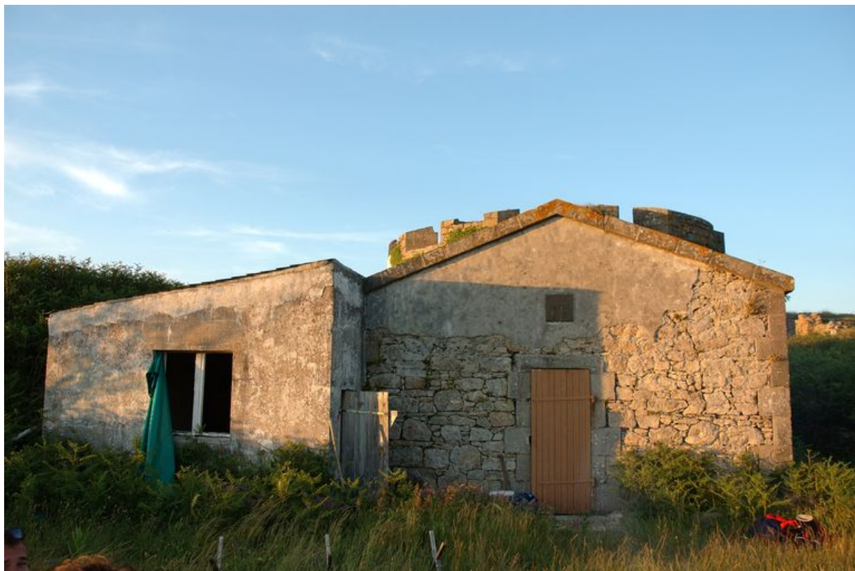
Vue du magasin à poudre et de l'abri léger en béton du fort Cézon
