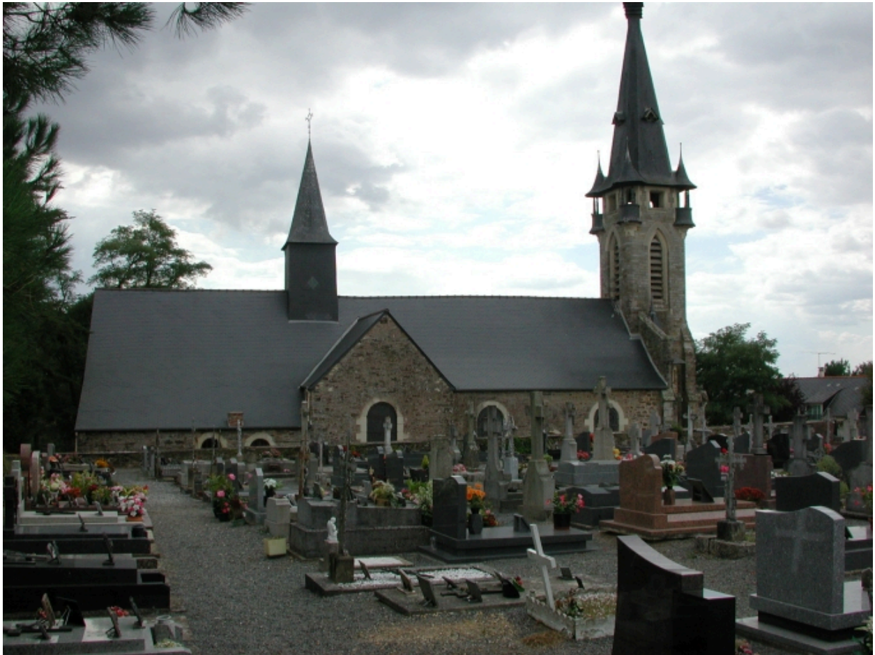
Vue générale nord
