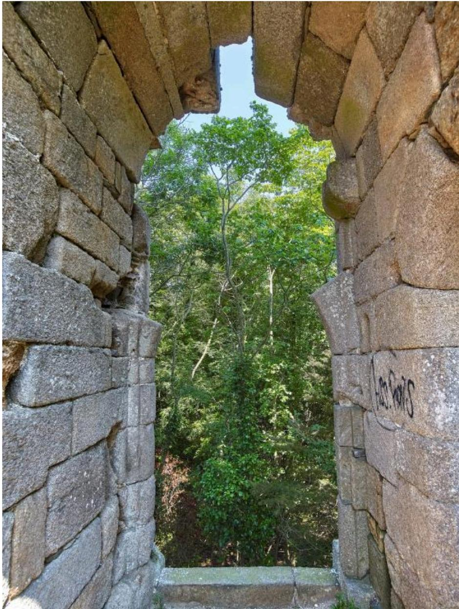
Vue du passage d'entrée du pont-levis. On voit le départ de la porte d'entrée (vraisemblablement en arc brisé) et de part et d'autre des piédroits moulurés, différents dispositifs de fermeture. L'ensemble est monté en pierre de taille de granite
