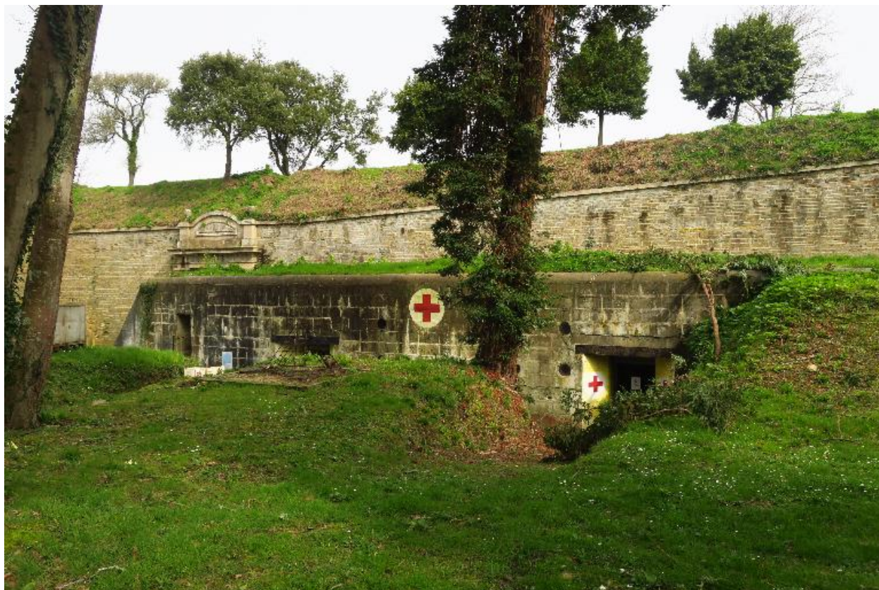
Le Palais, enceinte urbaine, courtine 20-21, abri infirmerie près de la porte Vauban.
