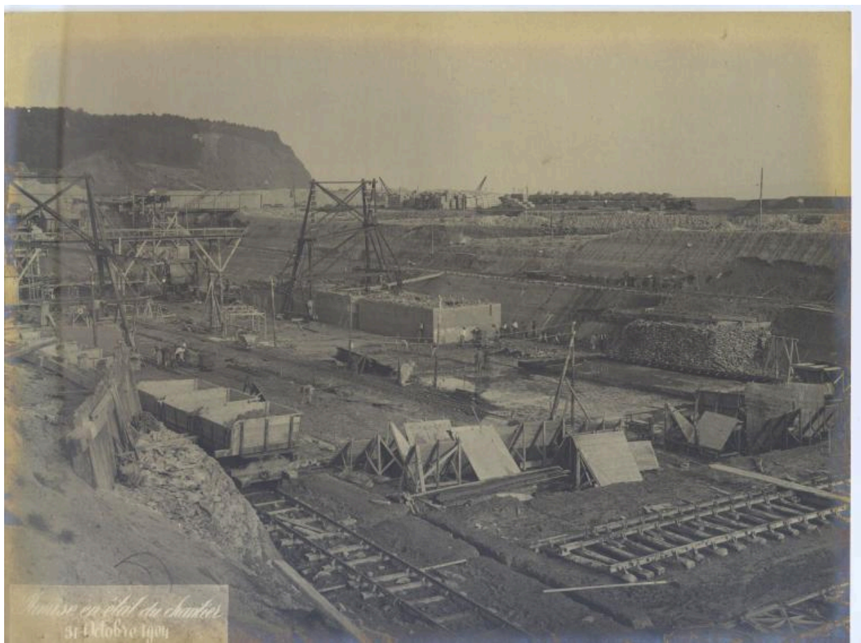
Travaux de la forme de radoub n°1 : blocs de fondation en cours de construction ; remise en état du chantier suite aux inondations, 31 octobre 1904
