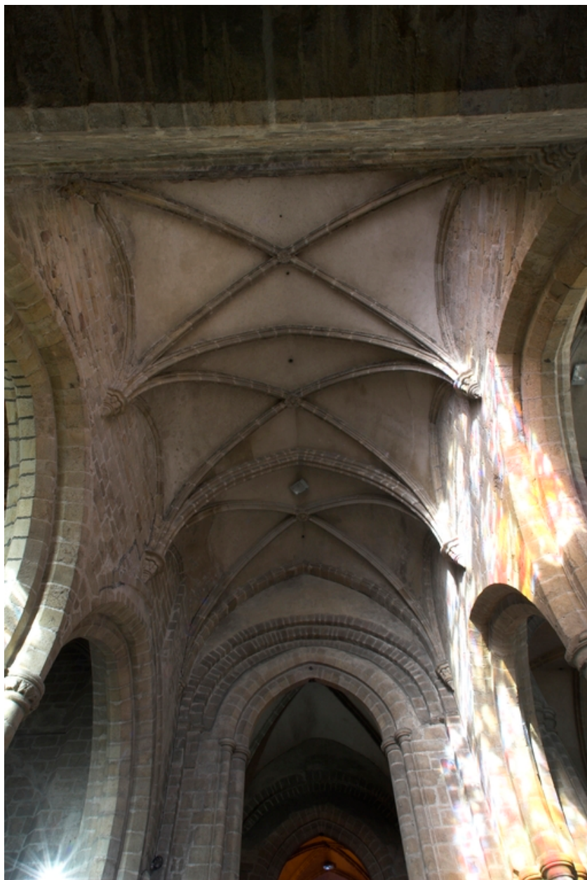
Vue des voûtes du bras sud
