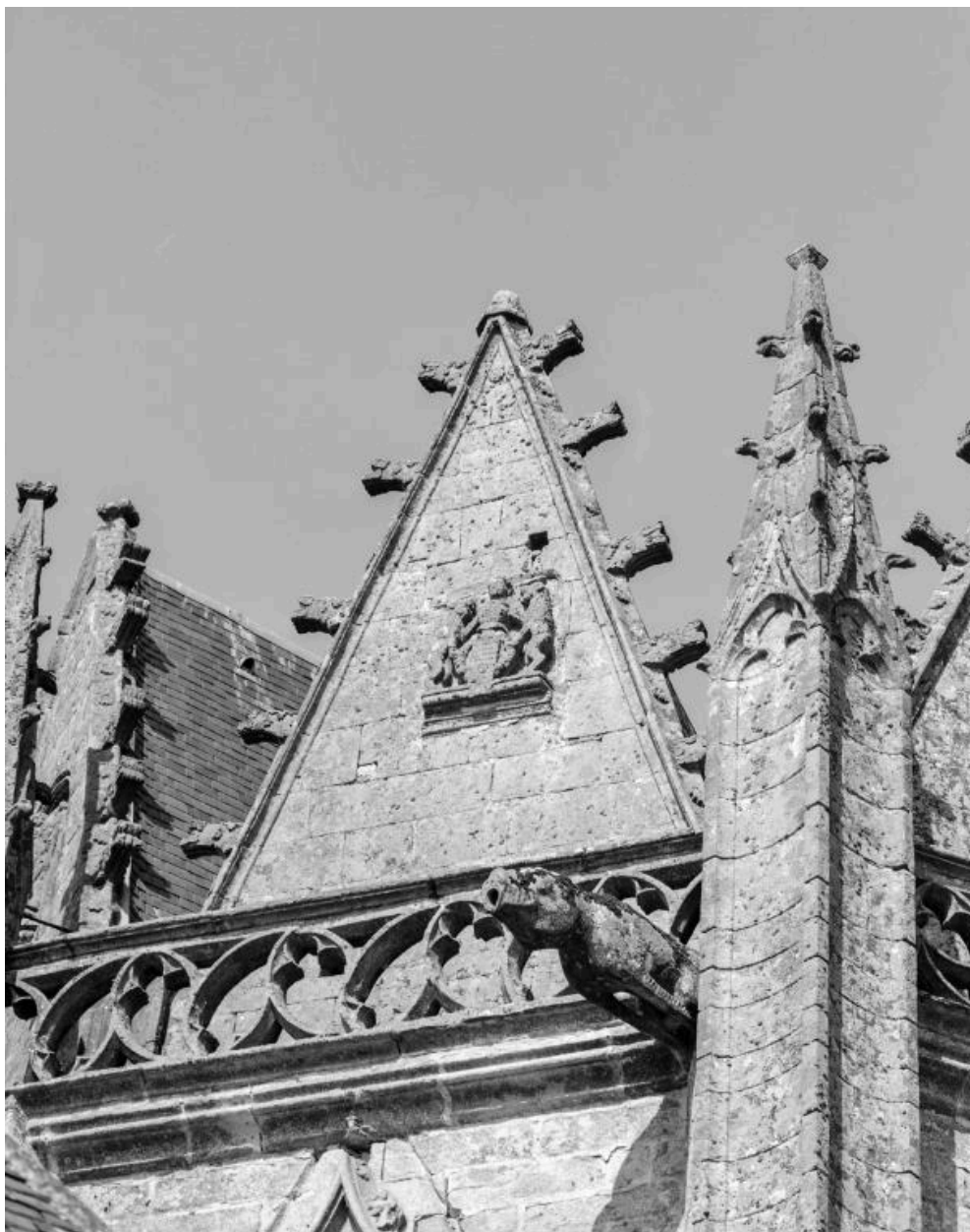
Détail armoiries sur le pignon du chevet à l'est.
