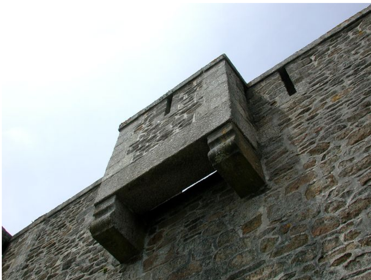
Vue du réduit de batterie de côte de la pointe de Kermorvan, bretèche à deux corbeaux
