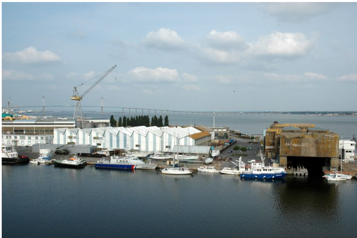
Environnement industrio-portuaire de la base de sous-marins de Saint-Nazaire : vue de l'écluse bétonnée
