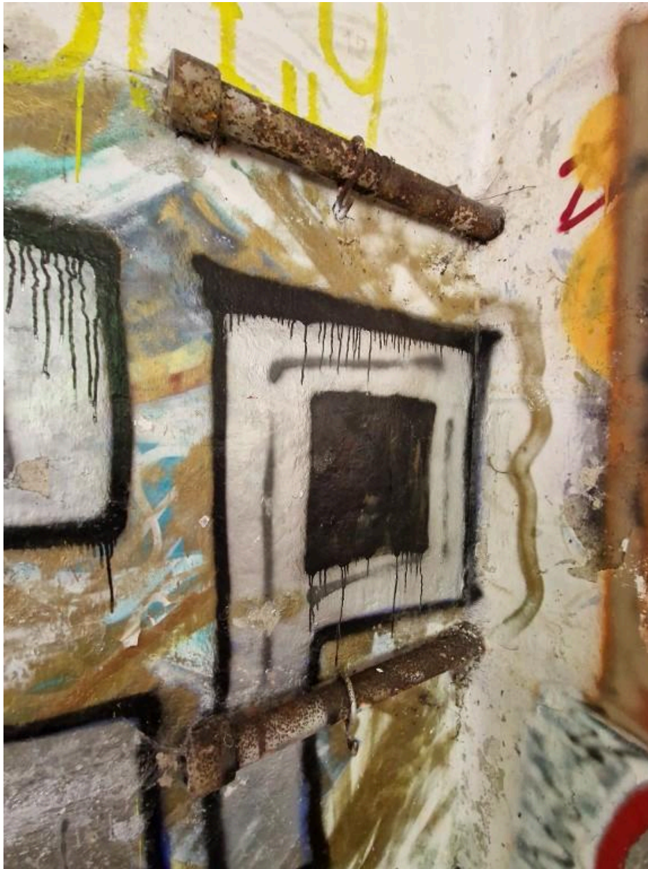
Vue intérieure de l'usine électrique du poste photo-électrique : supports métalliques pour crochets de hamac et numérotation (état en 2024)
