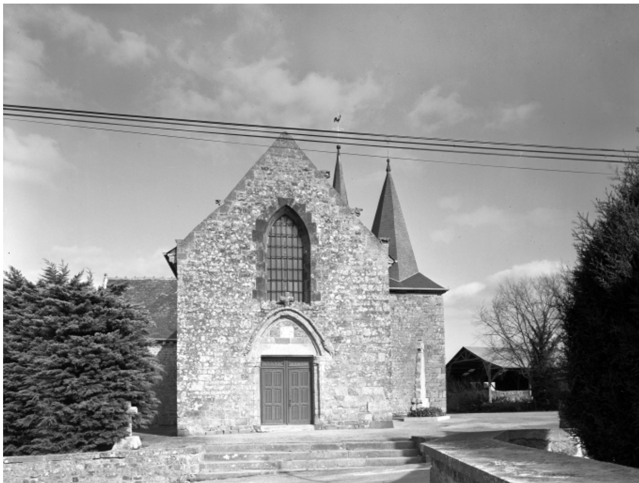
Elévation ouest : vue générale
