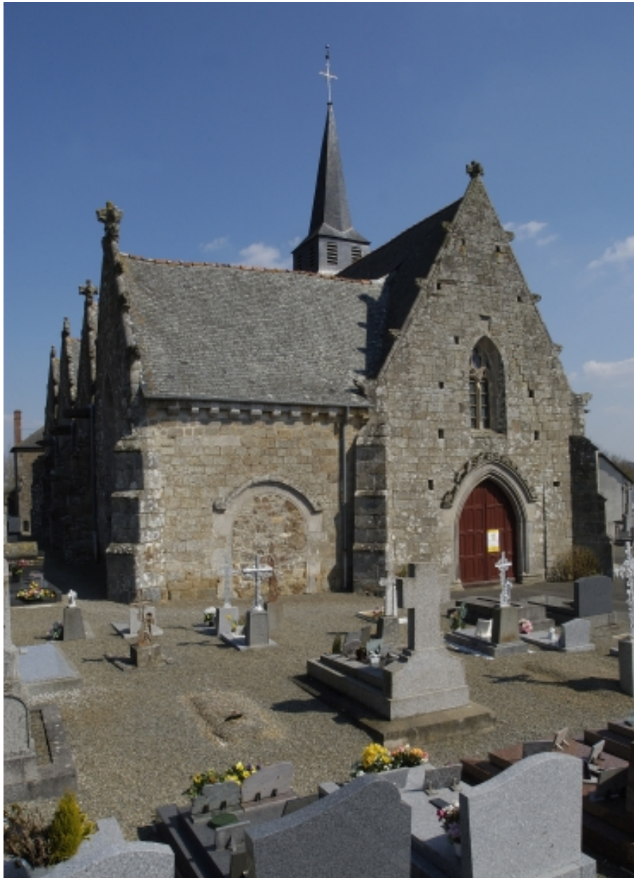
Vue ouest de l'église
