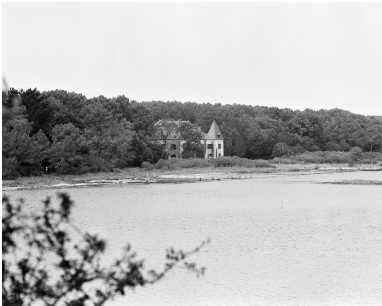
Vue de situation prise du sud-est
