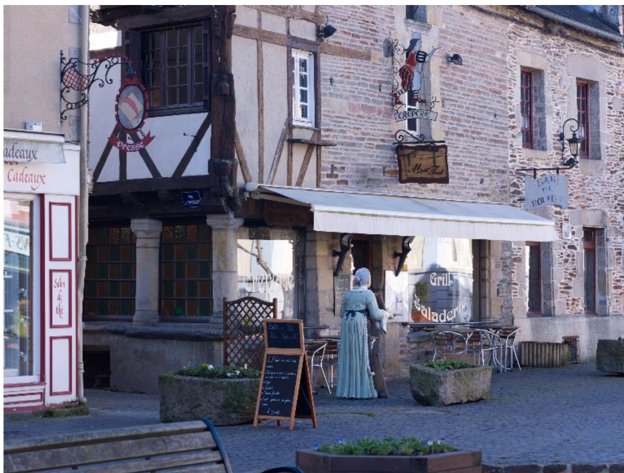
Maison : élévation nord vue de l'est (état en 2012)
