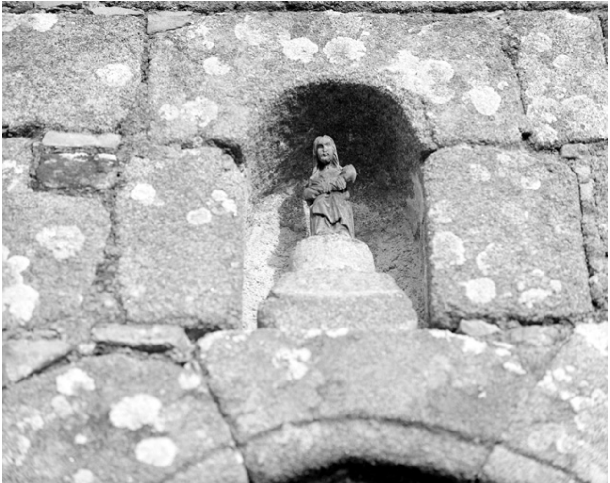
Élévation Ouest, porte : détail de la statuette
