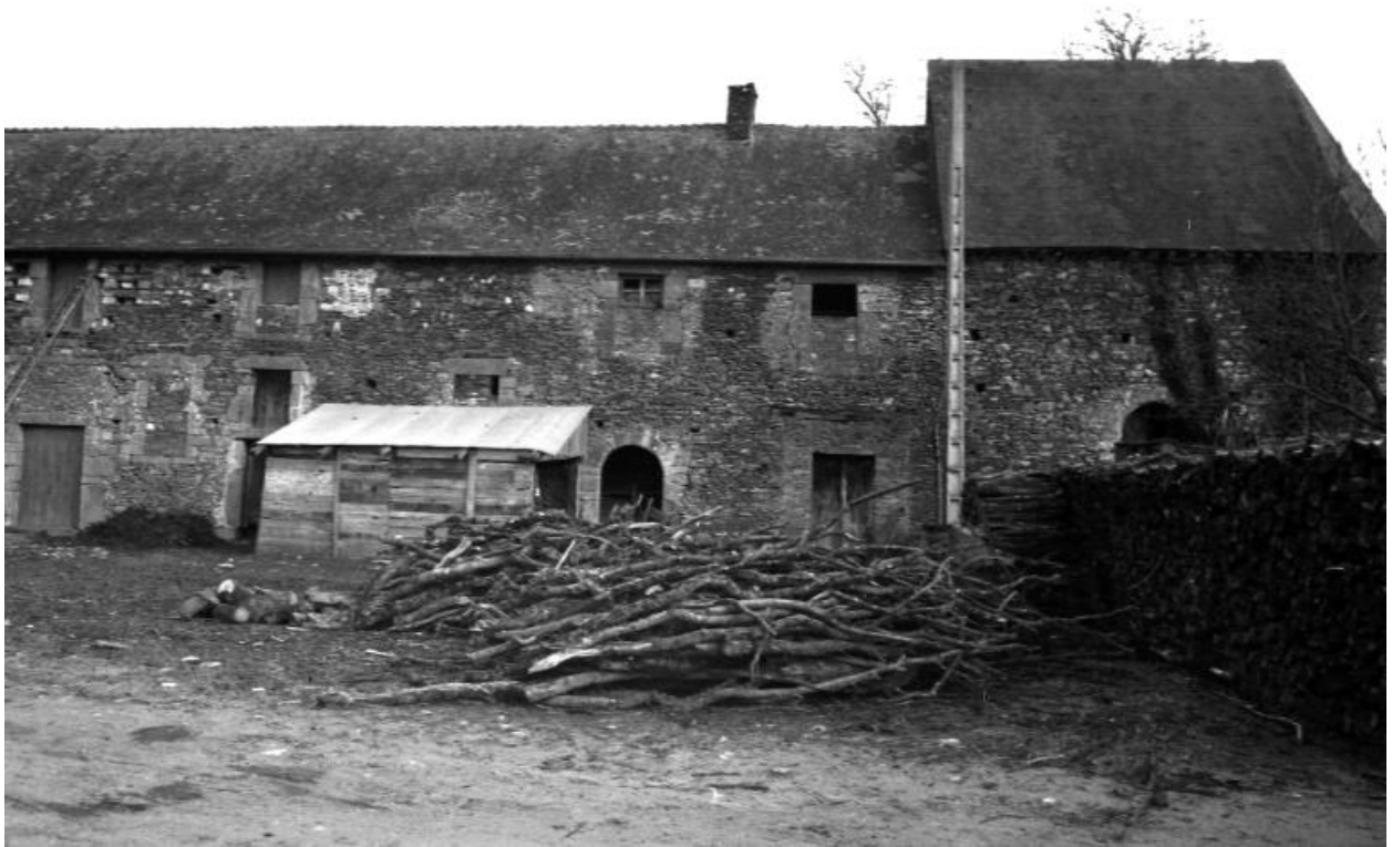
Ferme - Face est des bâtiments.
