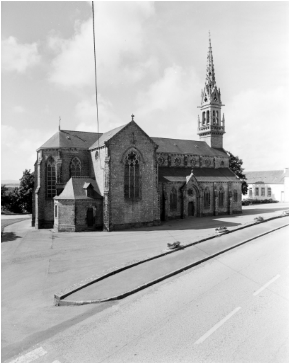
Pont-de-Buis-lès-Quimerch, église paroissiale Sacré-Coeur : vue générale nord, état en 1995
