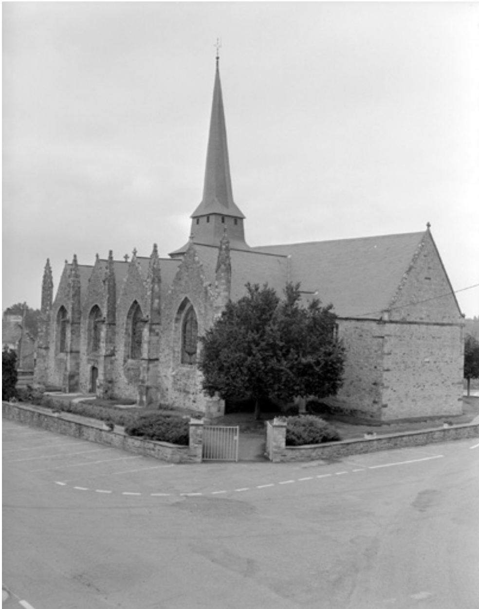
Vue générale de l'église
