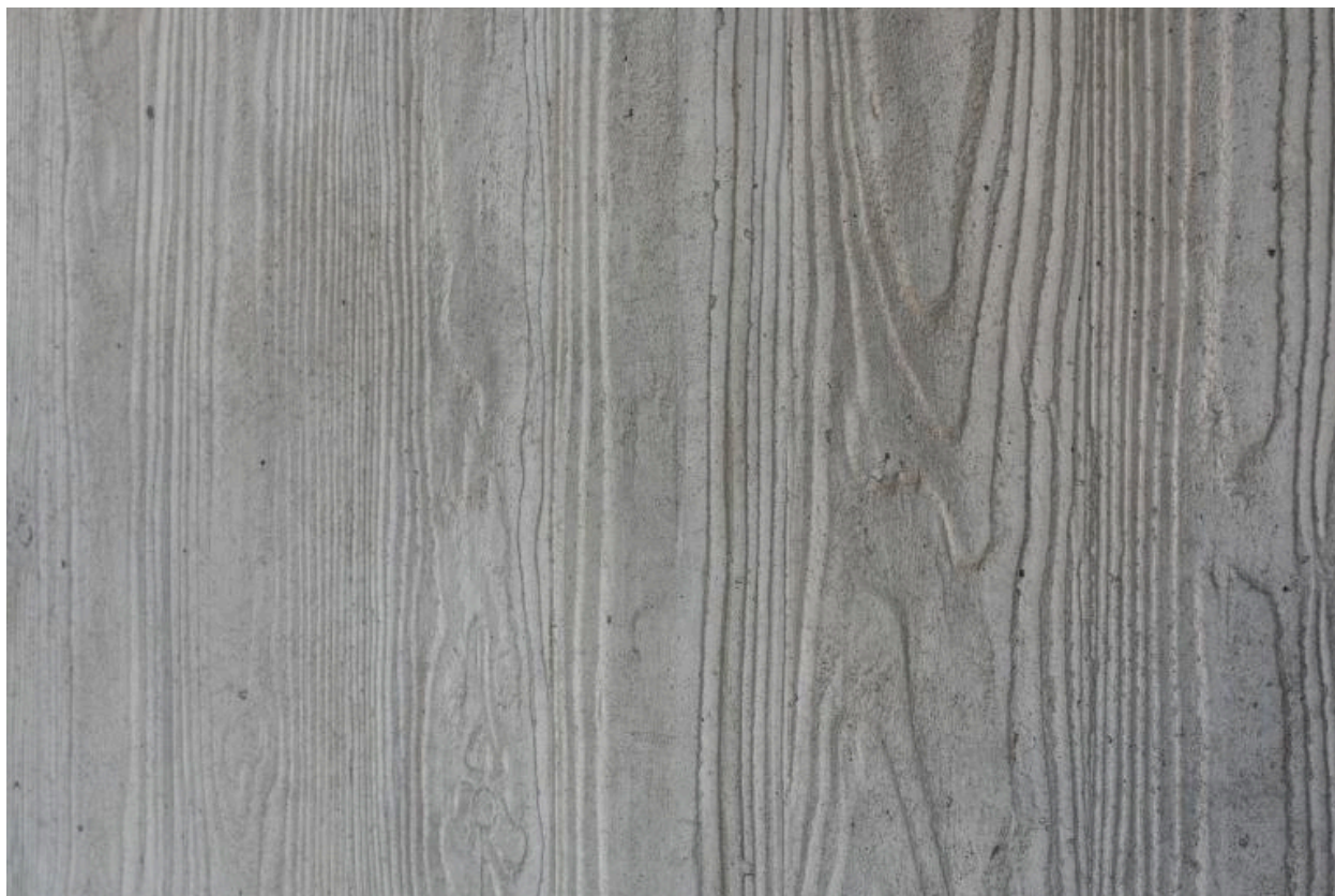
CDI : détail des moulures du béton.
