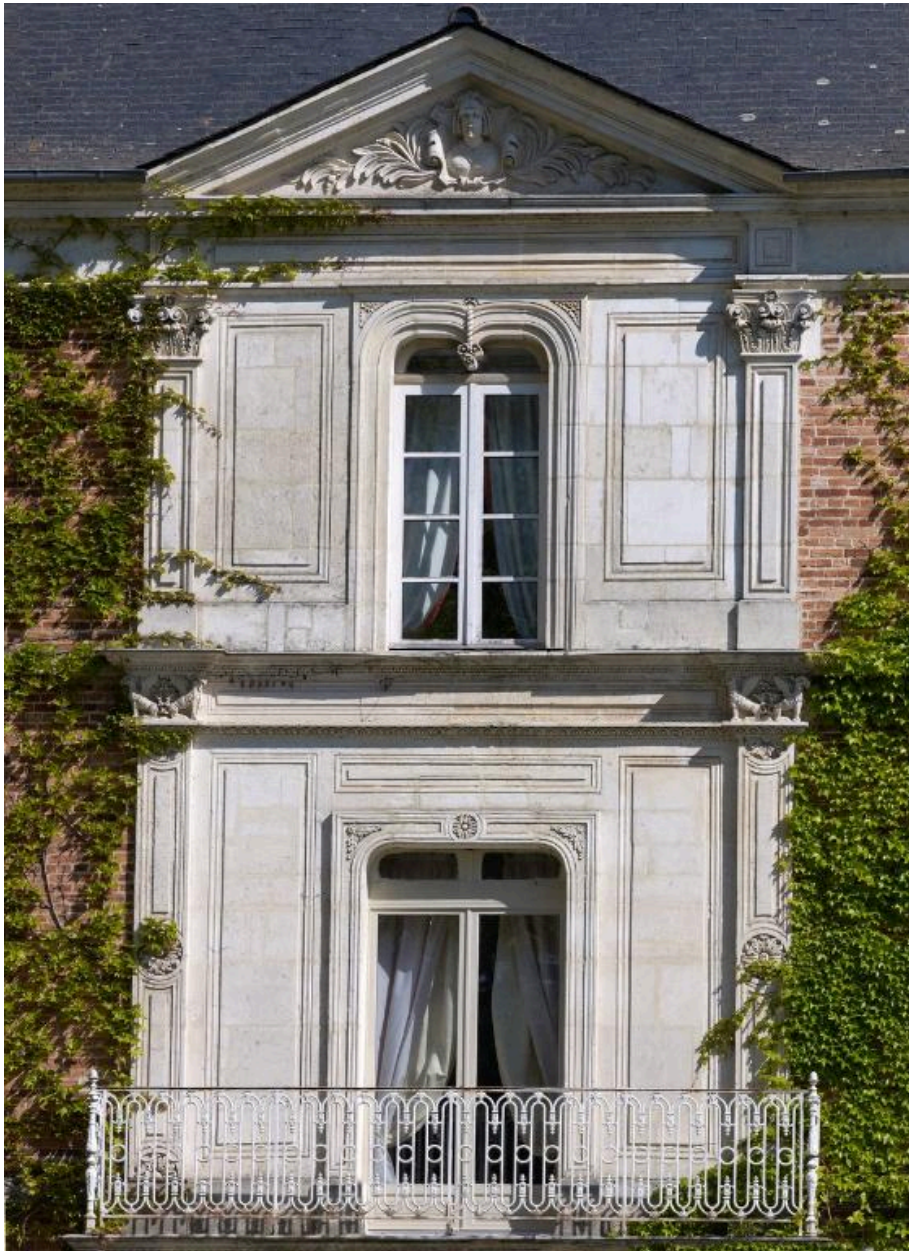
Façade sud, détail de la travée centrale
