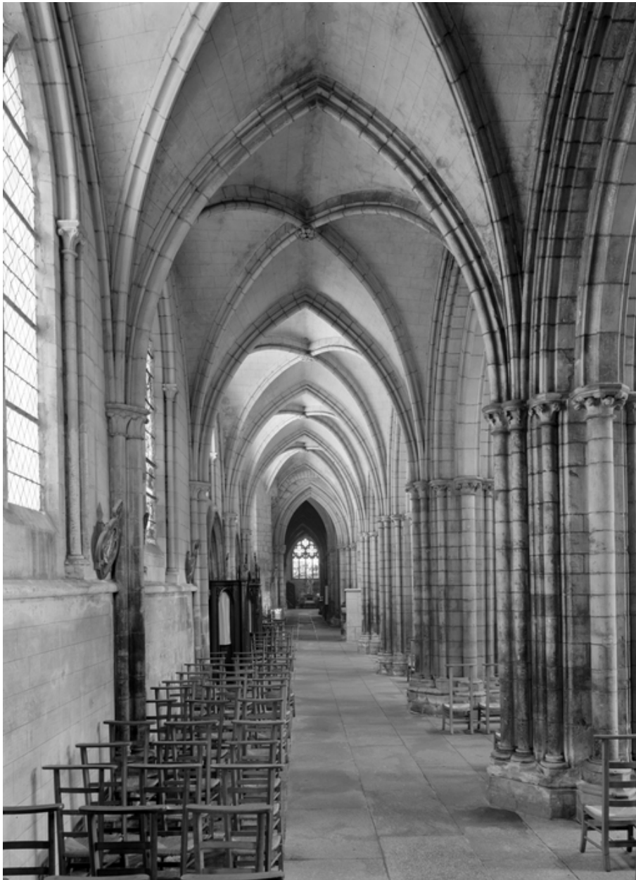
Vue intérieure axiale bas-côté nord vers l'est
