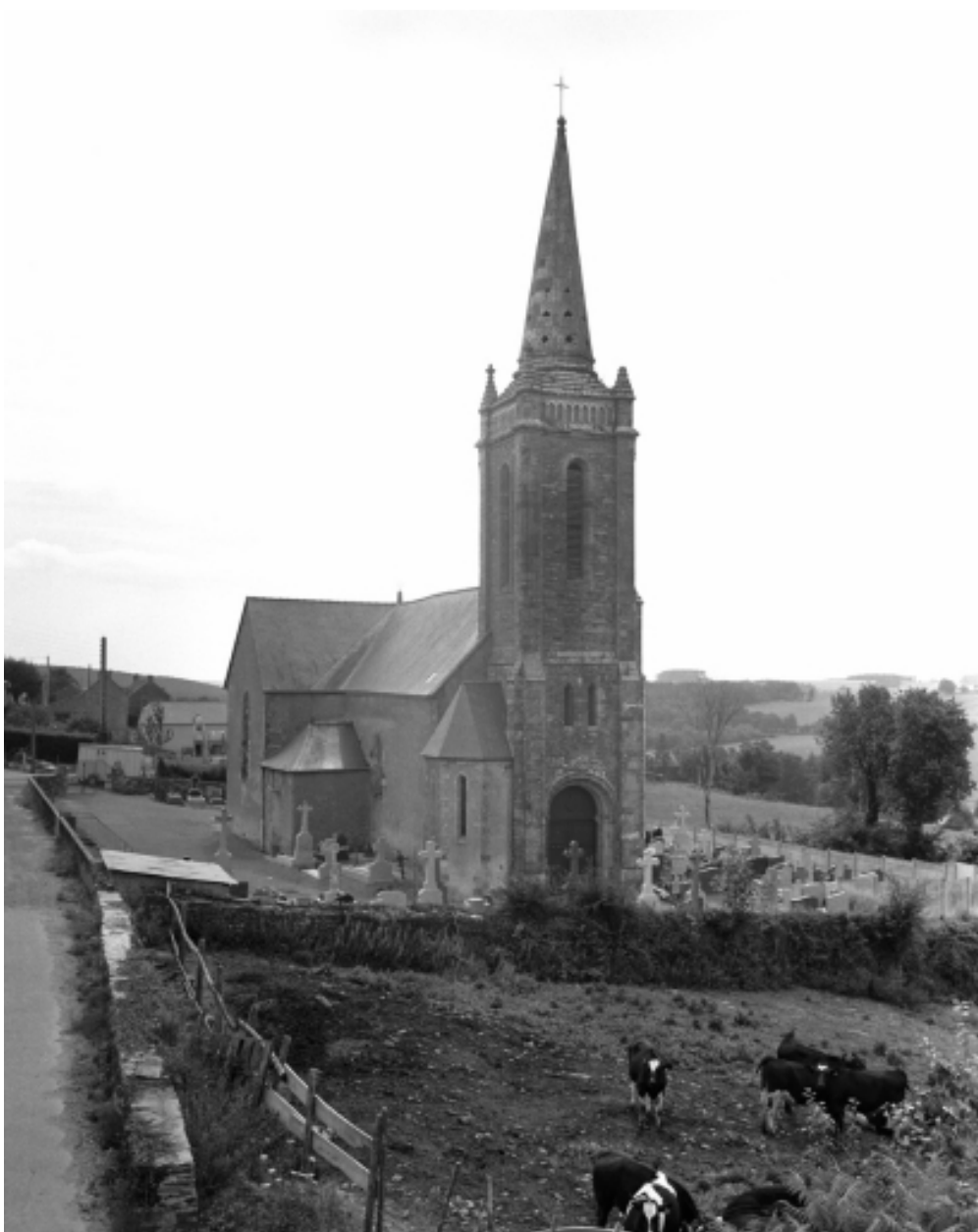
Elévation ouest : vue générale
