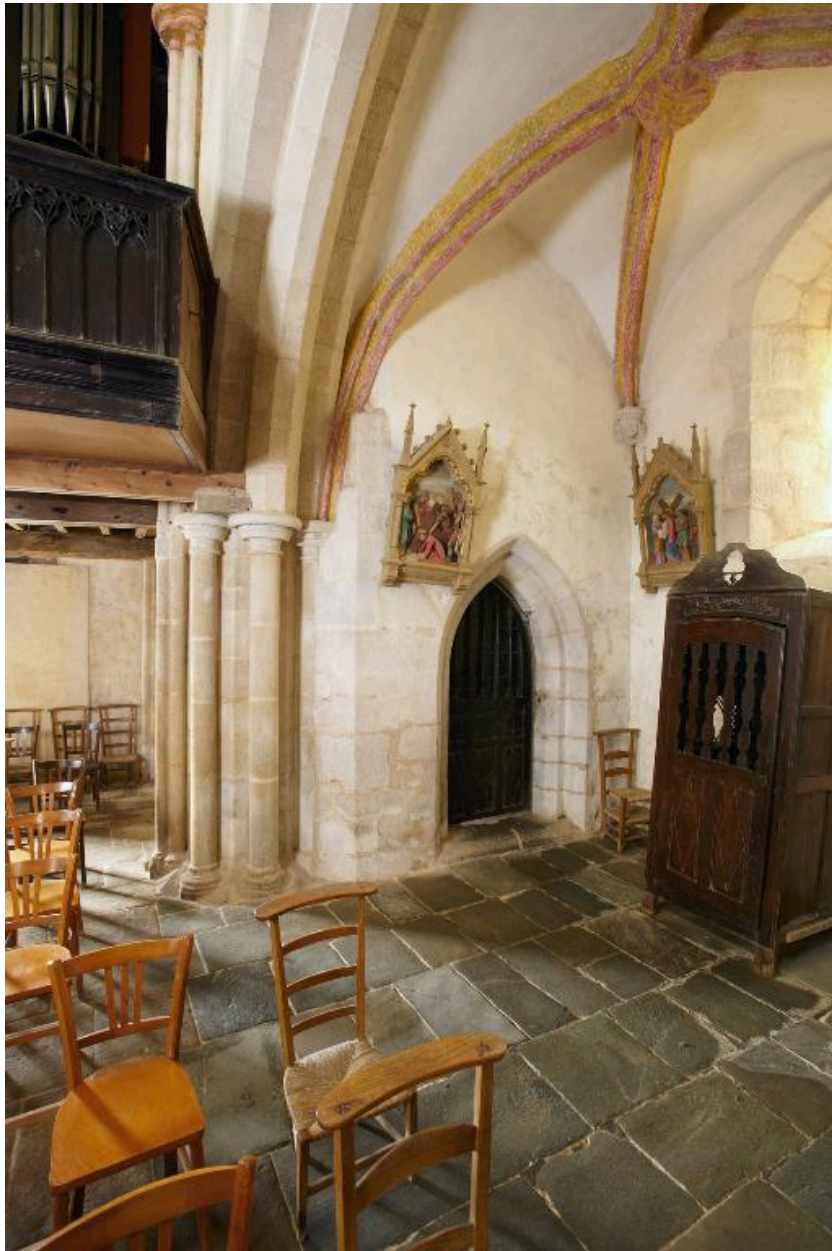
Porte d'accès dans le massif nord-ouest du côté du collatéral nord.
