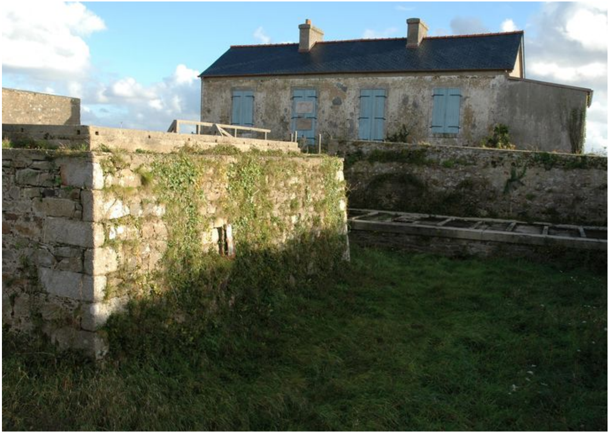
Vue depuis le nord-ouest : fossé sec et premier niveau de la tour-modèle. En arrière-plan, le sémaphore type 1861 avec ses volets bleus (état en 2004)
