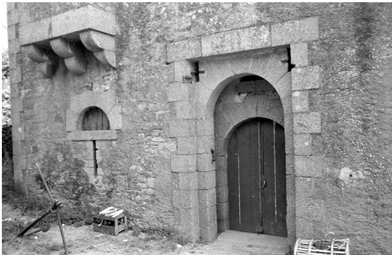
Vue du corps de garde crénelé n° 3 du bourg de Roscanvel en 1969 : porte d'entrée. A noter : la feuillure d'encastrement du pont-levis et le passage des chaînes de manoeuvre
