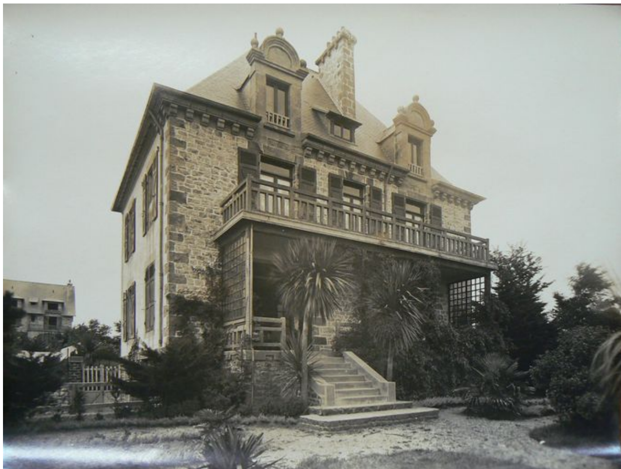
Vue ancienne de la façade de la villa Ker Odette, côté mer
