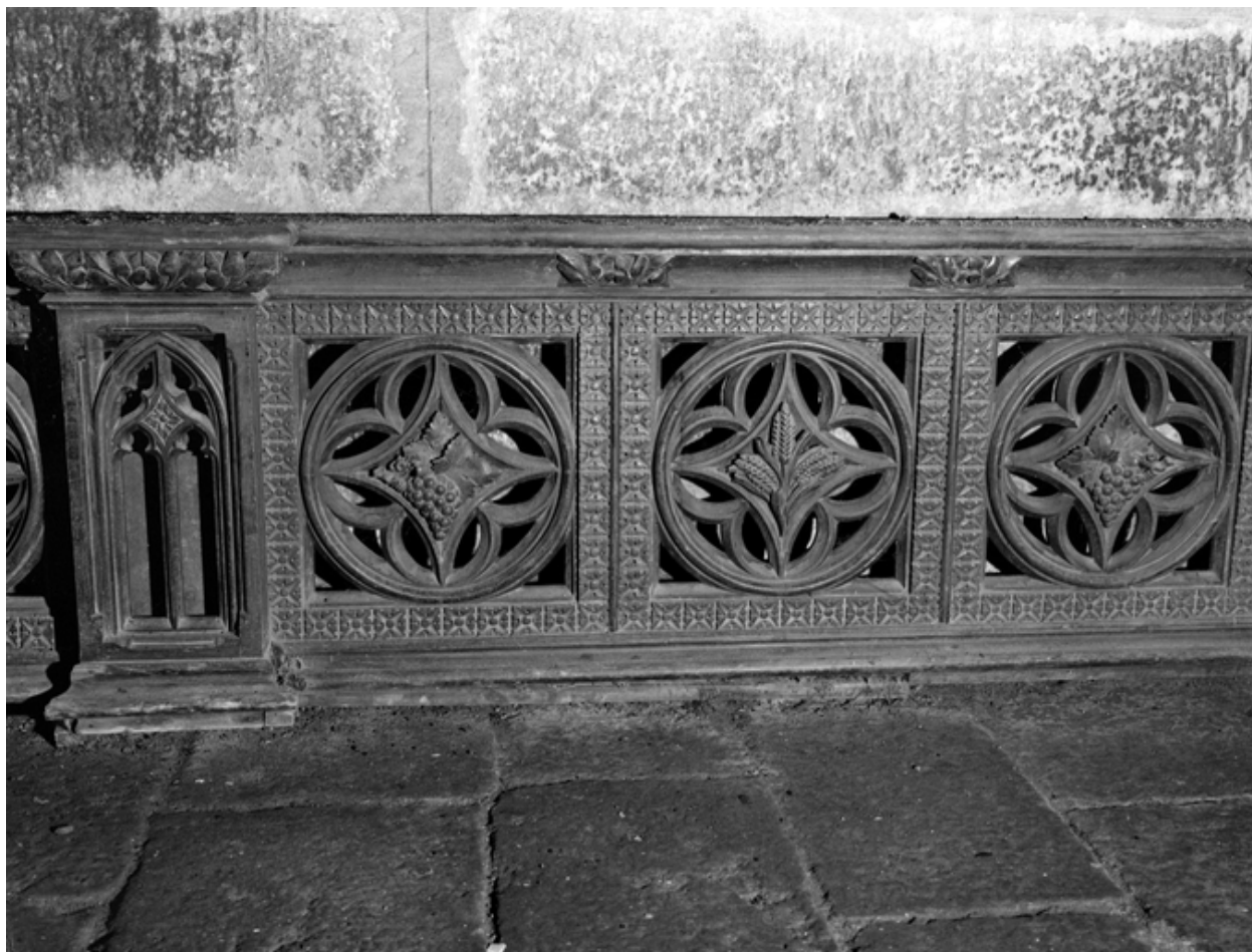
Balustrade de choeur déposée dans le bras nord du transept
