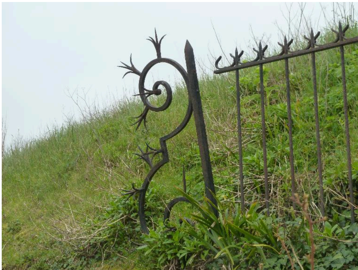
Le Palais, enceinte urbaine, bastion 20, grille défensive.
