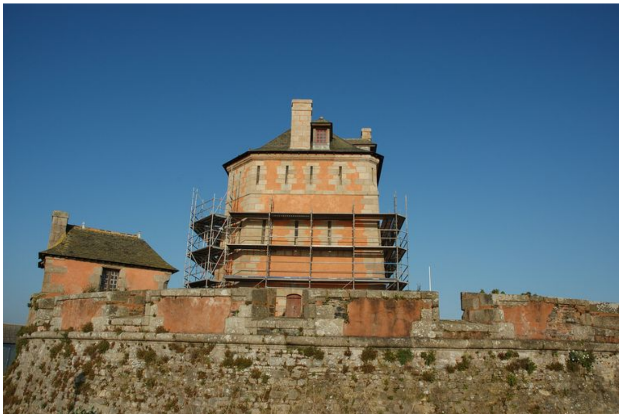
Vue de la Tour Vauban en restauration (mai 2007)
